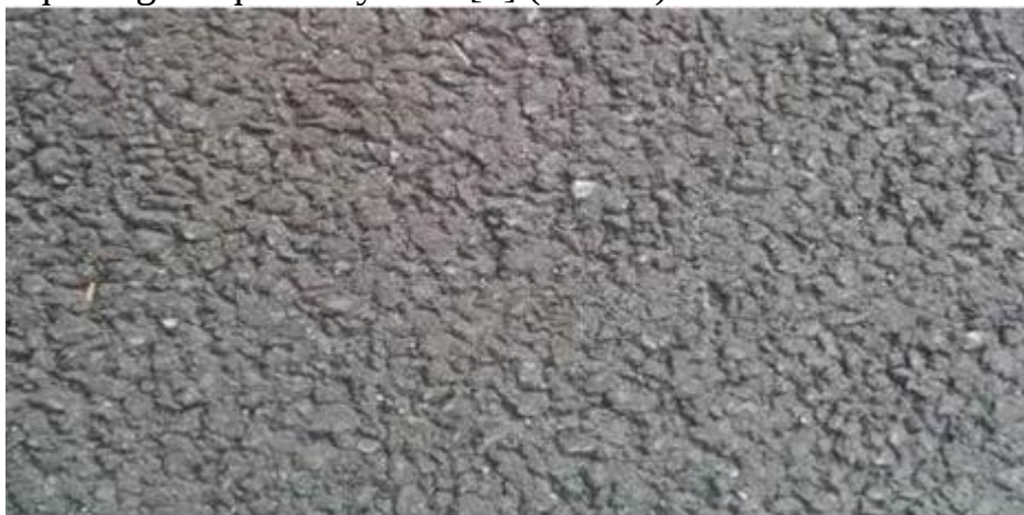
1-rasm. Yo'l qoplamalari va poroz asfalt (SMA-LA, shovqinni kamaytirishga mo'ljallangan asfalt).
